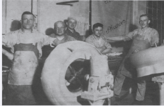
1928: Herstellung von Vollgummi-Autoreifen bei Phoenix in Harburg.
