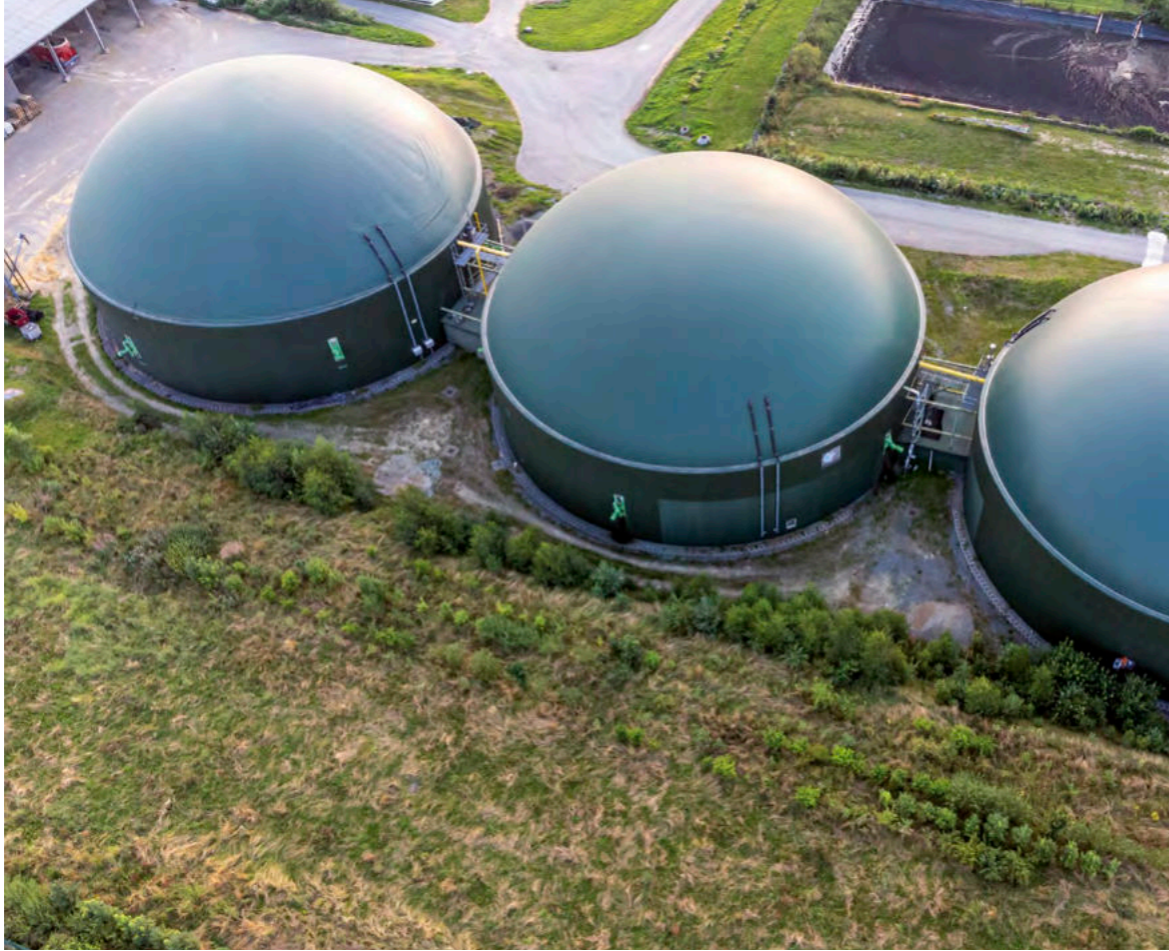
Energie-Lieferant Landwirtschaft: In Fermentern wird organische Substanz vergoren, um Biogas zu erzeugen.
